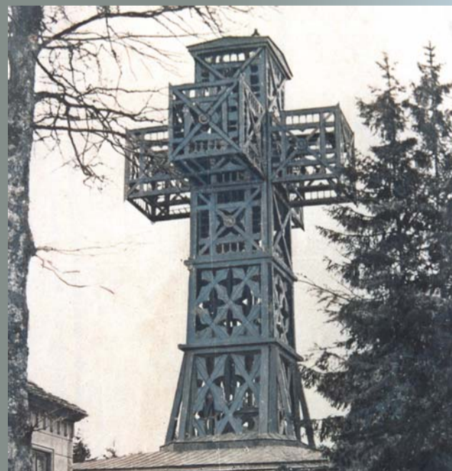
Das hölzerne Doppelkreuz fiel am 12. Juni 1880 einem Blitzschlag zum Opfer.
